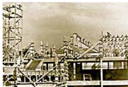
CONSTRUÇÃO DO NOVO EDIFÍCIO DO SERVIÇO ODONTOLÓGICO DA FORÇA PÚBLICA- 1967
